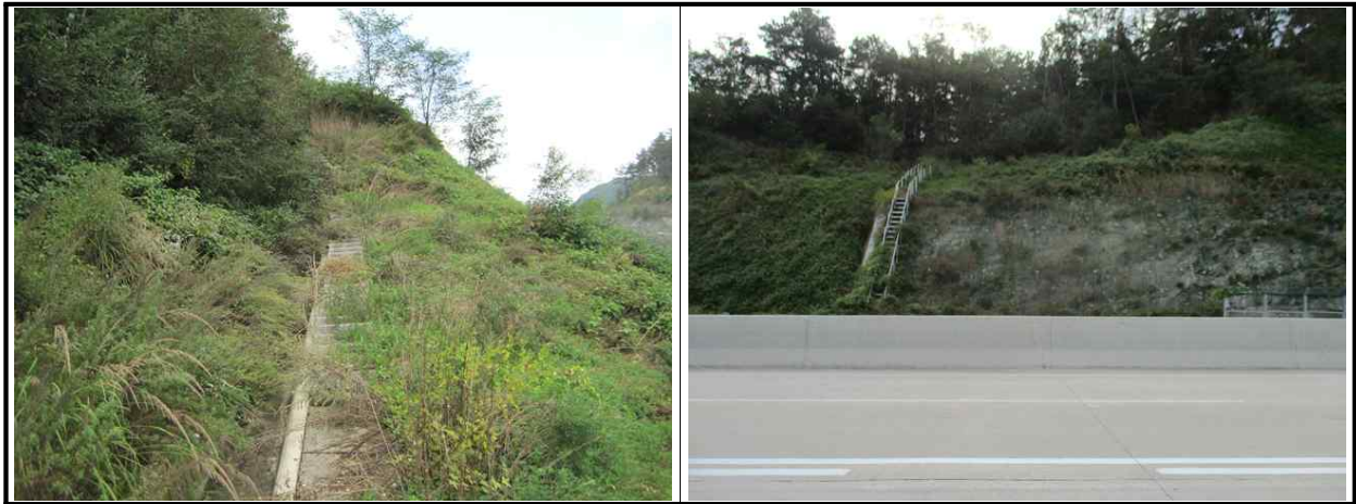
【그림 32.3.3】 배수시설 전경
