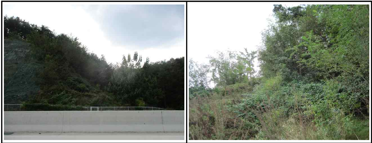
【그림 32.3.1】 상부자연사면 전경
